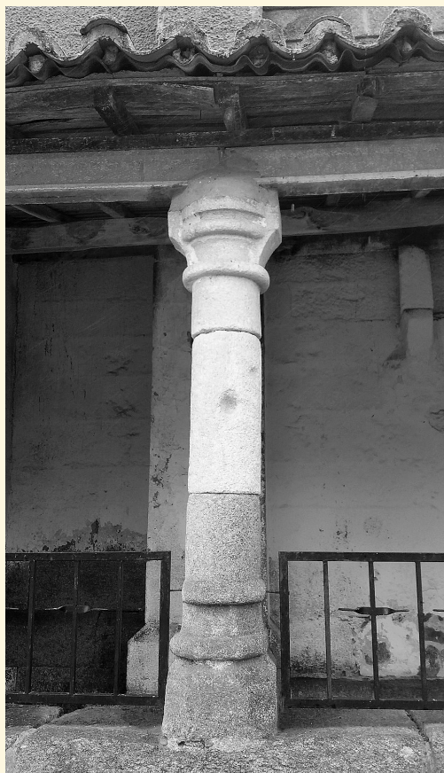
Columna del pórtico norte. La forman dos segmentos diferentes. El segmento inferior es similar al que soporta la pila de agua bendita.
