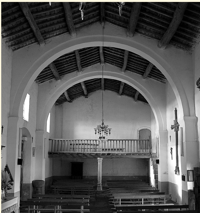
Las columnas, capiteles y arcos románicos que brindan su apoyo al techo.
