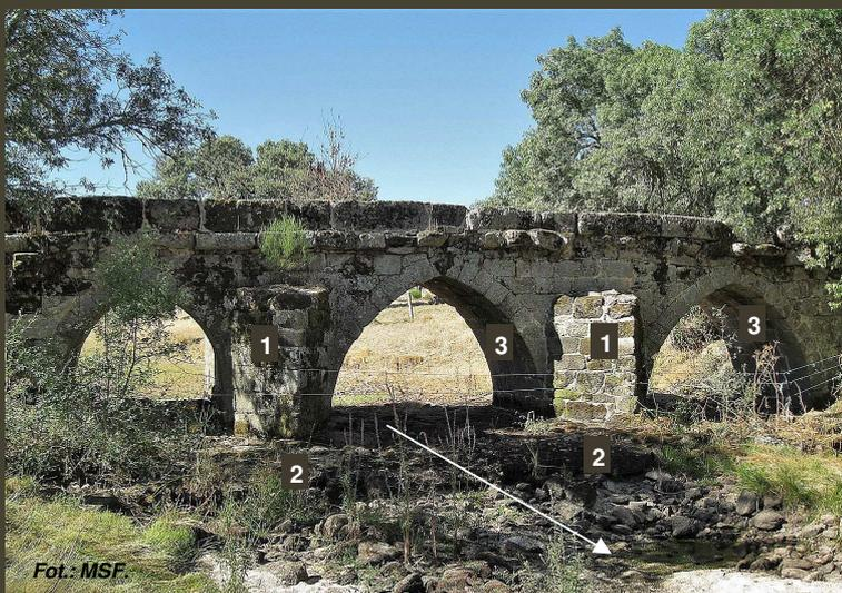
El puente medieval de la Albañeza, construido sobre posibles bases de pilastras romanas (2), presenta tajamares (1), elementos destinados a cortar la corriente para evitar así problemas de erosión y socavación en las cimentaciones, y tres arcos apuntados (3).
