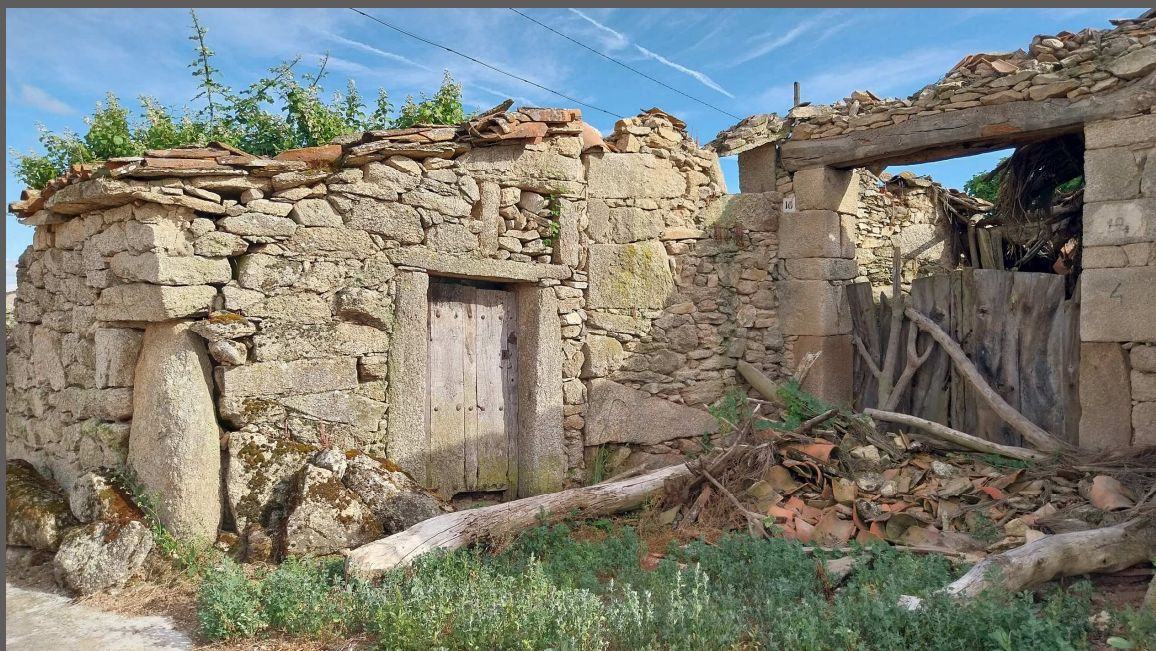
Casa de Antonio Pascual. Camino Zamora nº 6. Fotogr.: MSF.
