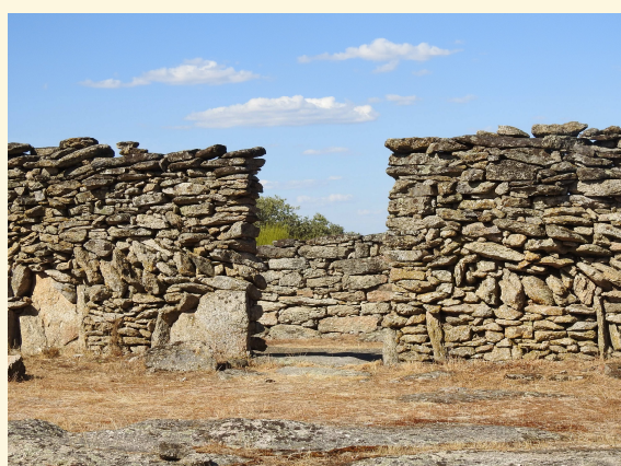
Construcción de piedra seca en el chivitero de Torregamones. Fotogr. Aitor Azpiazu.
